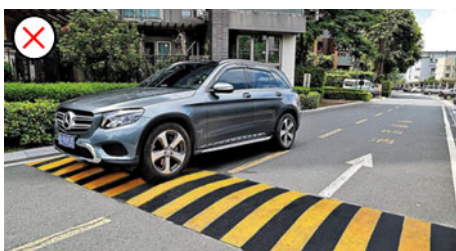
混凝土减速丘
